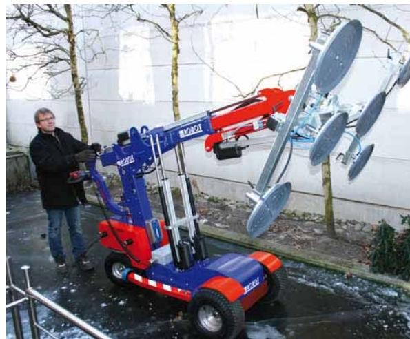
Un étang gelé est le seul accès possible pour effectuer des réparations du vitrage de toiture
